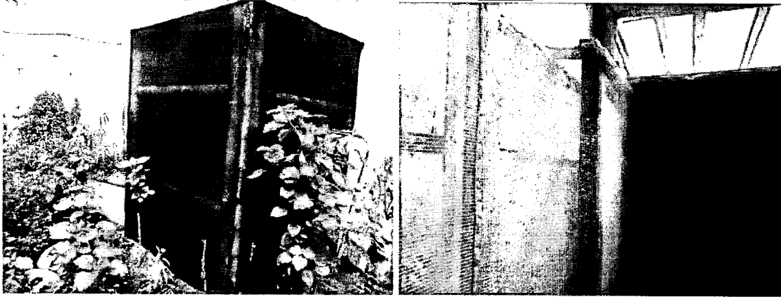
Fotos 9 y 10. Capas de protección adicionales instaladas en los módulos de transición de ingreso y egreso al Mariposario.
